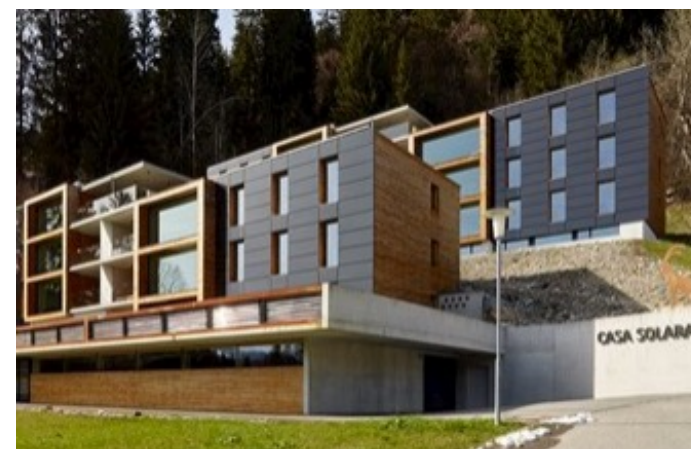
Impianto FV su facciata
