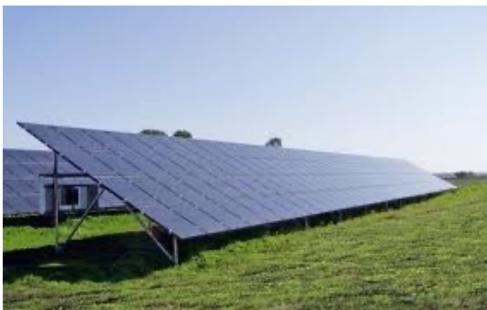
Impianto FV isolato
